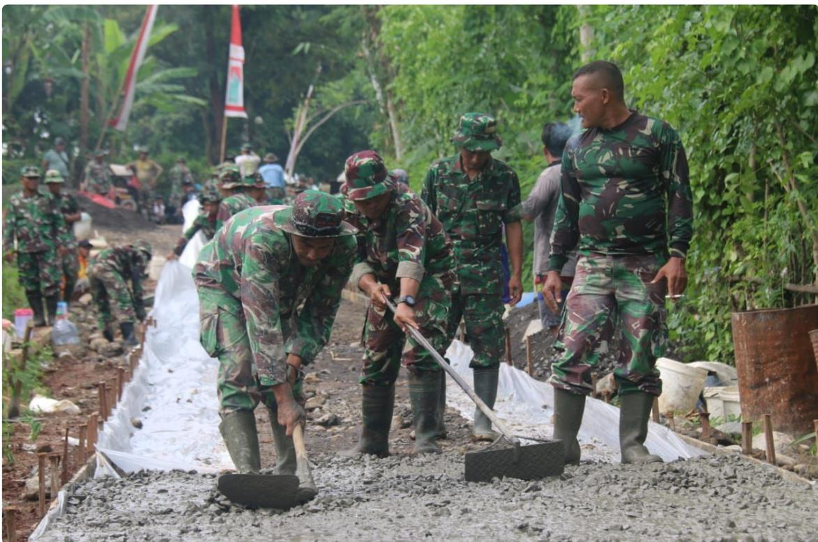
Diharapkan dengan proses cepat dan tepat bisa menghasilkan jalan beton yang bermutu bagus dan tidak cepat retak karena kurang proses pemadatan.
